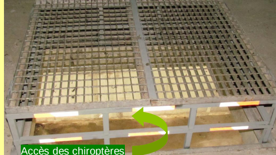
Photo 129 : Grille d'aération rehaussée (Source : Vinci Autoroutes/réseau ASF)
