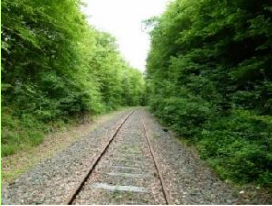
Photo 150 : Ligne ferroviaire Belfort-Delle en milieu forestier
