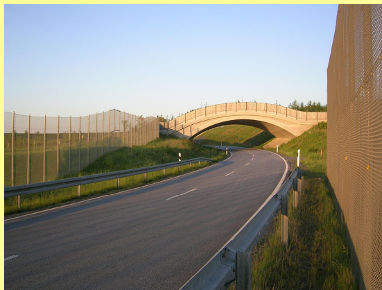
Photo 64 : Exemple allemand de clôtures de 4m mises en place de part et d'autre de la voie (Source : Kathi Märki/ NACHTaktiv & SWILD)
