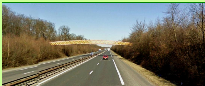
Photo 26 : Passerelle étudiée (Source : googlemaps)
