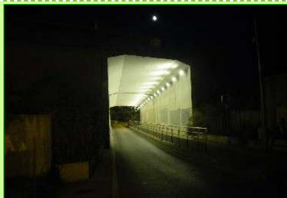
Photo 49 : Passage inférieur suivi par caméra thermique (source : Géraldine Kapfer/Groupe Chiroptères de Provence)
