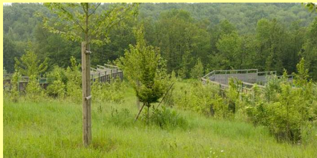
Photo 25 : Aménagement de l'ouvrage supérieur pour la Faune à Mareuil sur Cher - Autoroute A85 (Source Coffiroute)
