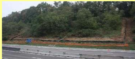
Photo 124 : Emprise chantier de l'écopont (Source Vinci Autoroutes/réseau ASF)
