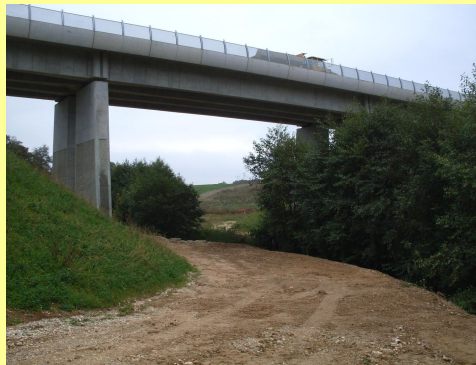
Photo 55 : Ouvrage de la VÈZE (Source : RFF)
