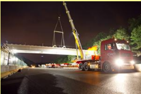
Photo 125 : Phase chantier, installation du tablier par grue de nuit (Source Vinci Autoroutes/réseau ASF)
