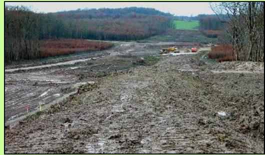
Photo 2 : Chantier LGV Rhin-Rhône. Les travaux peuvent conduire au défrichage de vastes emprises forestières. (Source CEREMA DT Est)
