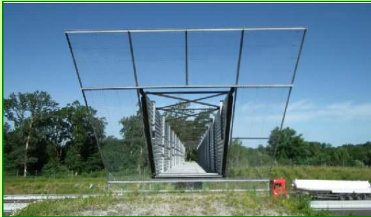
Photos 36 et 37 : Chiroptoduc de l'autoroute A65 – Pau-Langon – Aliénor/Eiffage TP
