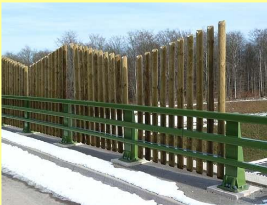
Photos 74 et 75 : Dispositifs de guidage utilisant des poteaux installés sur des ouvrages supérieurs : LGV (à gauche) (Source : ECOLOR), l'autoroute A63 (à droite) (Source : EGIS Environnement)
