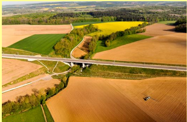
Photo 39 : Pont-rail de la Vèze sur la LGV Rhin-Rhône préservant la ripisylve sous l'ouvrage – (Source : RFF)
