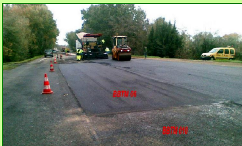
Photo 19 : La pose du BBTM a été intégrée dans une opération de rénovation déjà programmée (Source : CG 13).
