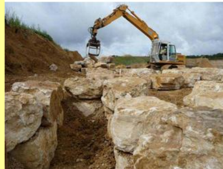
Photo 91 (haut) : Vue de l'intérieur de l'ouvrage
