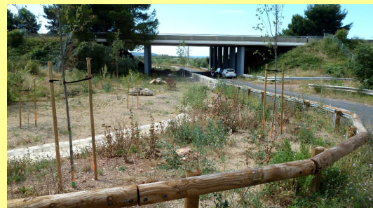
Photo 118 : Conversion d'un ouvrage inférieur en passage mixte sur l'autoroute A9 (34) (Source : Écologistes de l'Euzière / Vinci Autoroutes/réseau ASF 2012)
