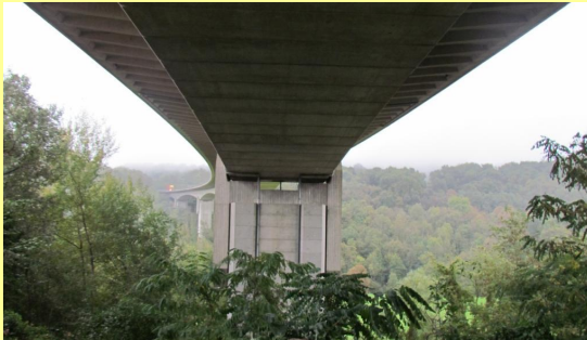
Photo 128 : Viaduc de l'A64 (Source Vinci Autoroutes/réseau ASF)
