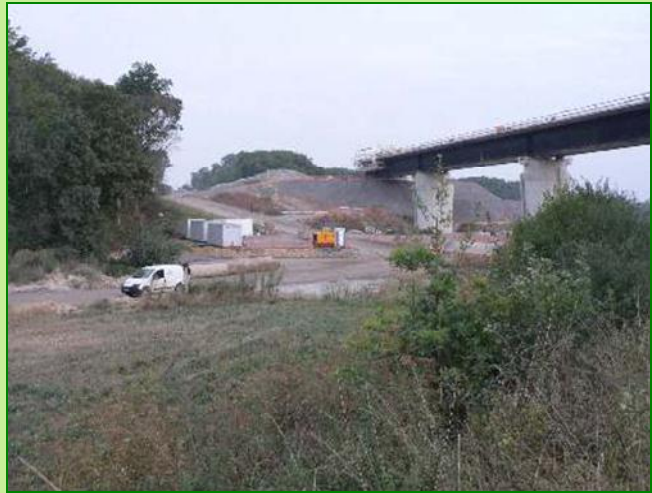
Photo 5 : Chantier de la LGV Est à Bénestroff - (Source : Néomys)
