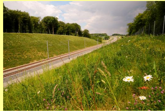
Photo 132 : Talus végétalisé le long de la LGV Rhin-Rhône à Châtenois-les-Forges (90) (Source : RFF)
