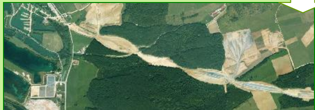
Illustration 12 : LGV Est en phase travaux – 1999
