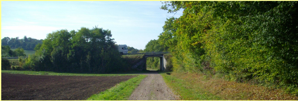
Photo 48 : - Cordon de végétation connecté à l'ouvrage (source : Atelier des Territoires)
