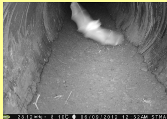
Photo 121 : Passage d'un Chiroptère dans une buse de 800 mm de diamètre, 65 m de longueur, réalisée sous l'A64. Cliché obtenu environ 3 mois après l'achèvement de l'éco-duc (Source : Nature Midi-Pyrénées / Vinci Autoroutes/réseau ASF, 2012)
