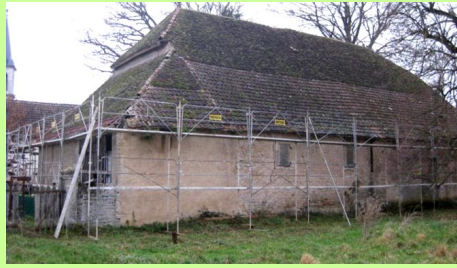
Photo 111 : château d'Amange avant aménagement
