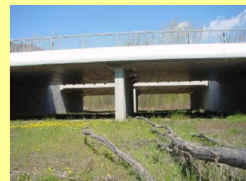
Photo 106 : Ouvrage de franchissement permettant d'accéder à la zone de compensation
