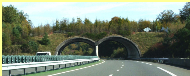
Photo 24 : Eco Pont sur l'autoroute A89 (Source Vinci Autoroutes/réseau ASF / OGE)
