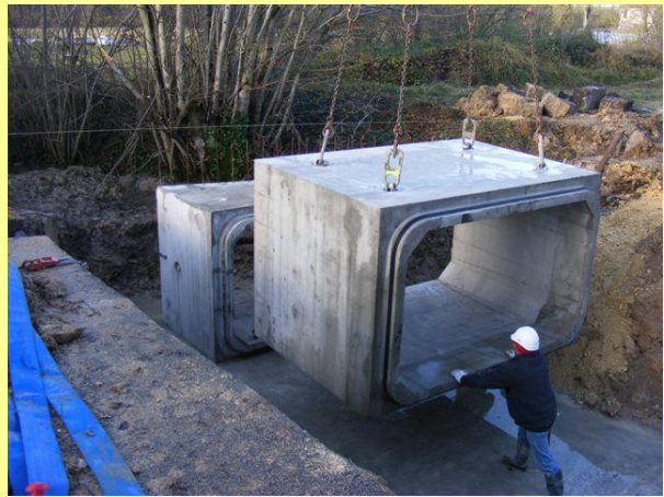
Photo 101 : Mise en place des modules préfabriqués
