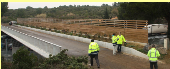
Photo 114 : Ouvrage du chemin des poissonniers (Source : Écologistes de l'Euzière)
