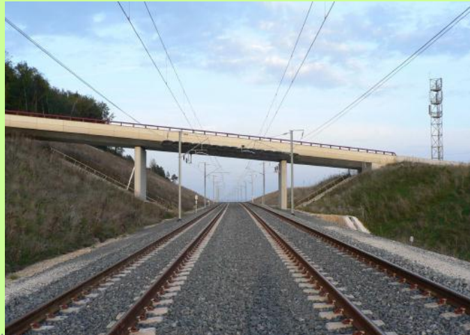
Photo 139 : Pont route du village de Creuë - (Source Néomys 2008)
