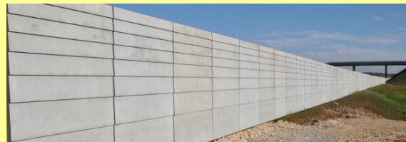
Photo 71 : Mur antibruit (LGV Rhin Rhône) (Source : RFF)
