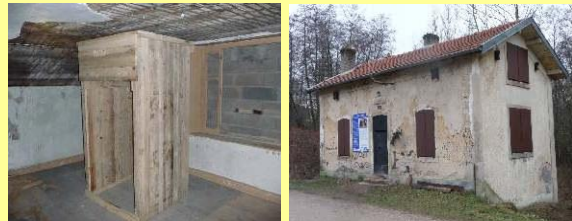
Photos 78 à 81 : Maison éclusière de Gripport (Source CPEPESC Lorraine)
