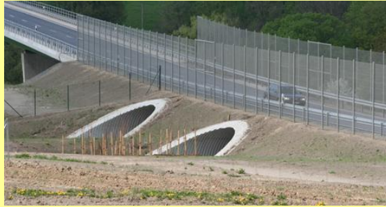
Photo 69 : Passages à chauve-souris équipés de plantations-guides et de clôtures d'une hauteur de 4 m parallèles à la route S170 à Ottendorf au niveau de Friedrichswald – Allemagne (Source : G. Hintemann)
