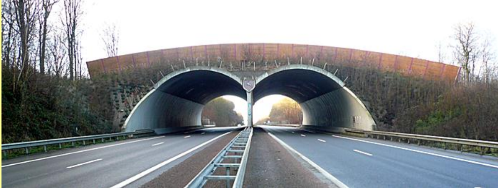
Photo 73 : Écran d'occultation sur un ouvrage supérieur de la RN 52 - Forêt de Retz (Source DIR Nord)
