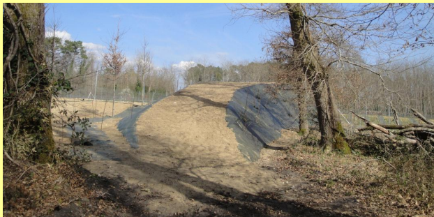
Photo 30 : A65 – Tremplin vert conduisant à un passage spécifique (cf. Structure légère) (Source : Eiffage TP)
