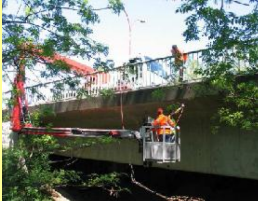
Photo : 137 : Opération d'entretien sur un ouvrage d'art (Source : Sophie Bareille)
