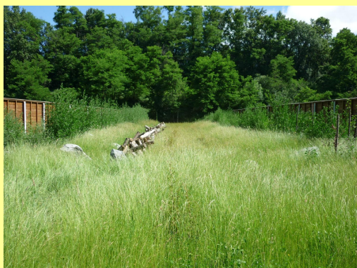
Photo 61 : Ecopont de l'autoroute A7 – 2012 (Source : LPO Drôme / Vinci Autoroutes/réseau ASF)
