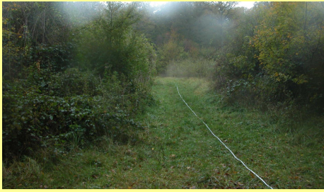
Photo 59 : Tablier végétalisé permettant une bonne connexion entre les habitats situés de part et d'autre de l'ouvrage RN57 (Source : CEREMA DT Est)
