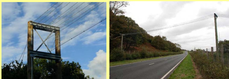
Photos 31 et 32 : Exemple de structure (fils tendus, grillage) mise en œuvre sur le réseau routier hollandais – (Source : A & W Ecologisch onderzoek)
